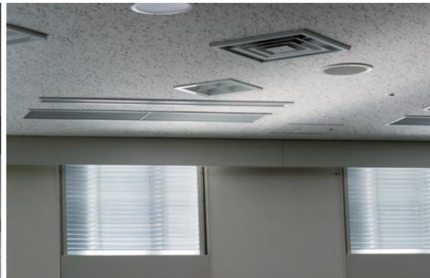
奥に4ヶ所あるランマ部上部に採光ルーバーを設置しました。採光ルーバーの室内側には凹凸のついたアクリルパネルを組み込み、室内へ入る明かりを拡散させています。
