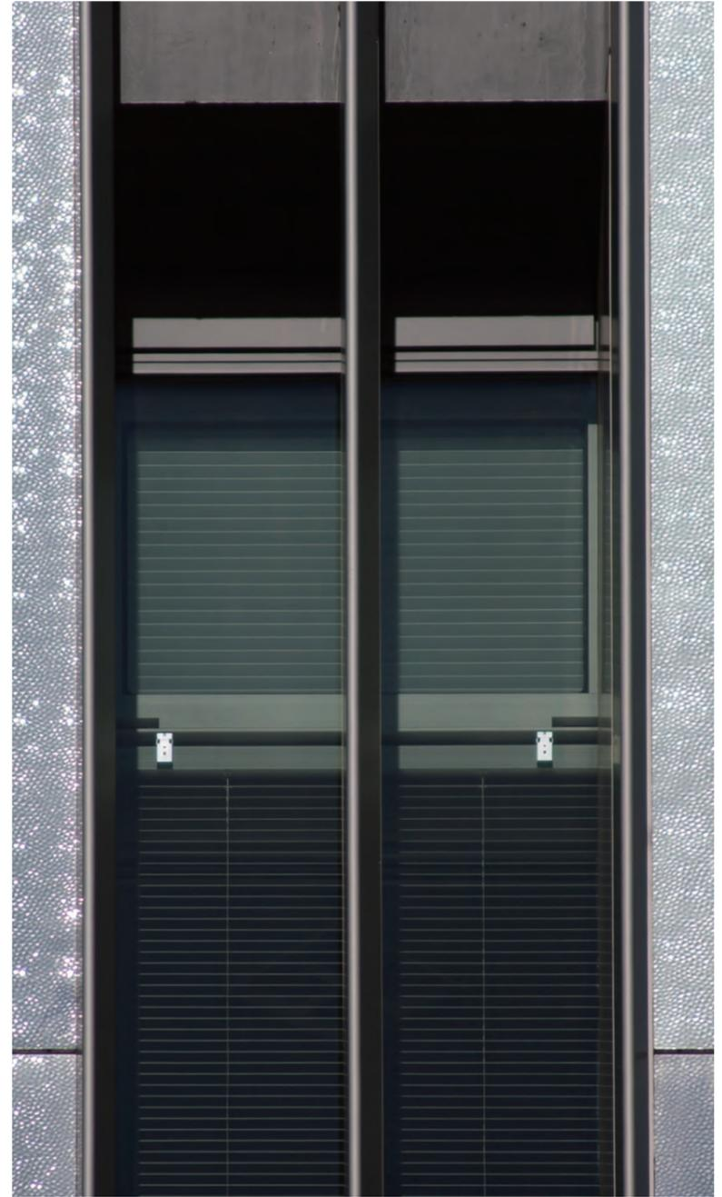
自然採光システム（採光ルーバー）を東南面の欄間部に配置しました。特殊形状のルーバーに太陽光を反射させ、室内天井面を照らします。採光ルーバーは照明エネルギー削減とBCP対応に不可欠です。
