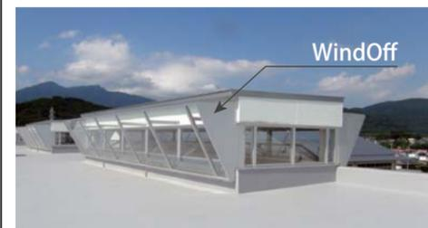
常時開放型排気窓「WindOff」はサッシの外部側に遮風板を設けています。遮風板により、風上、風下関係なく、サッシの外部は負圧となり、室内の空気が外部へ排出されます。
