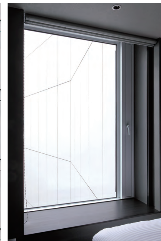
ACW-04 | ホテル階 縦換気サッシ (閉鎖)
