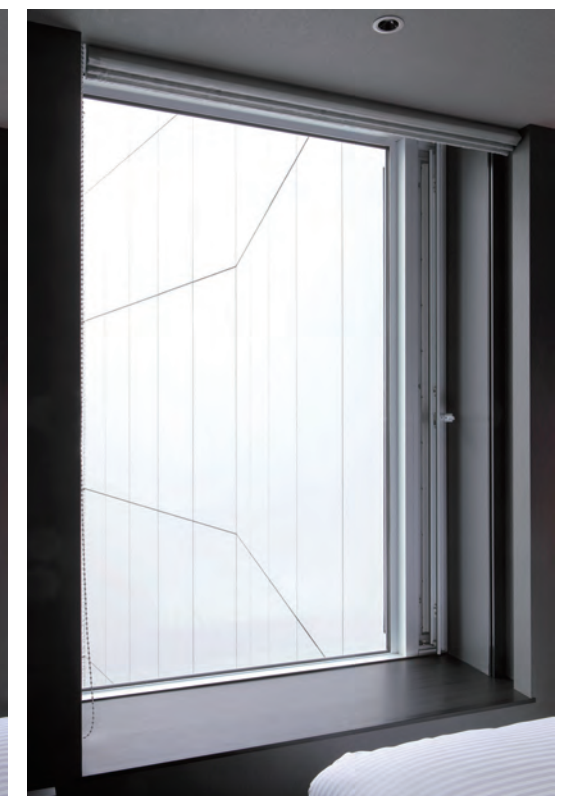
ACW-04 | ホテル階 縦換気サッシ (開放)
