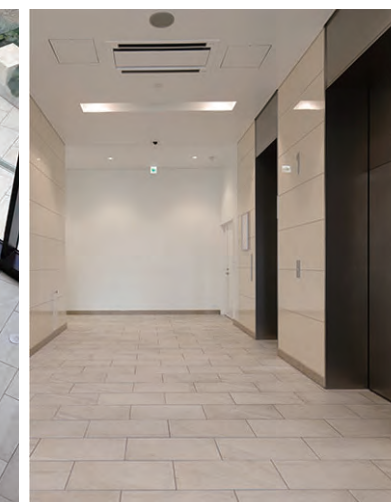
エレベーターホール内装床面
