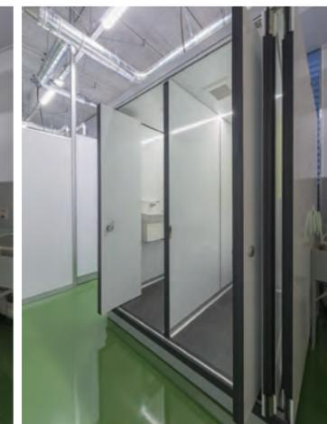
壁付タイプの大便器で床の清掃性を高めた大便器ブース。シャワートイレのリモコンは独立したデザインの大きなボタンが分かりやすく、操作するたびに発電するので電源が不要。洗浄リモコンは着座時間に応じて1つのボタンで洗浄水量の大・小の切替えができるようになっている。
