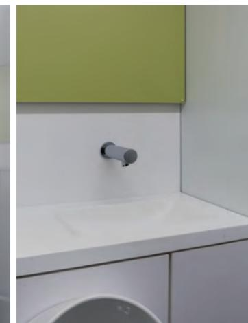
凹凸の少ないボウル一体成形の洗面カウンターには壁付タイプの自動水栓を完備1段高い位置に小物を一時置きできるドライエリアを備えている。
