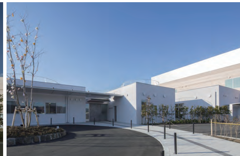
エントランスファサード
