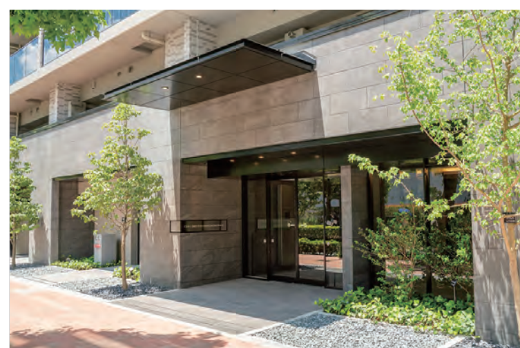
1Fエントランス 外装壁面
