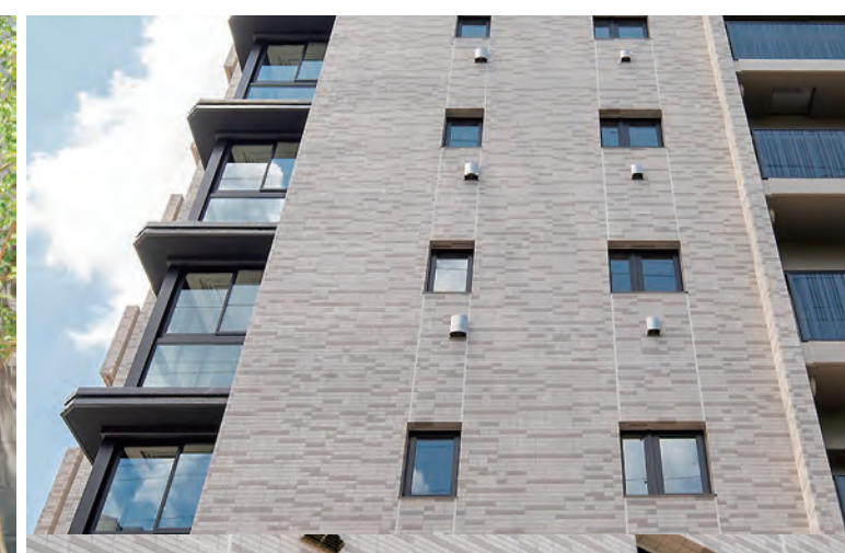
西側 外装壁面
