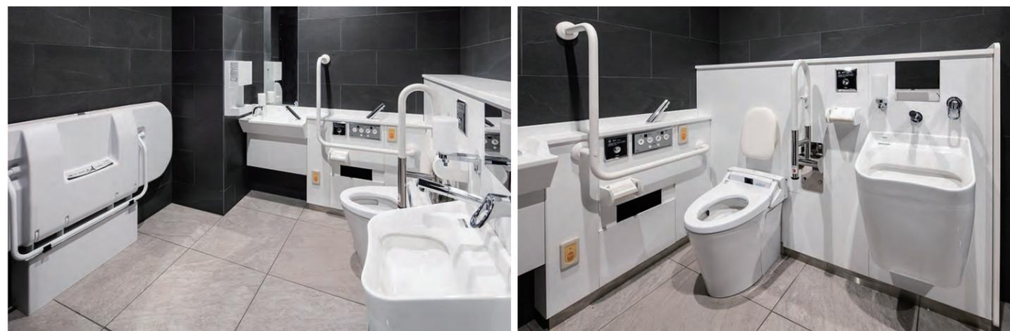
一般トイレと同様にモダンで落ち着いた空間。万が一に備えた非常用ボタンや、視認性の高い大型のリモコンを設置。オストメイト対応流しの他、ゆったり使える大ききサイズのユニバーサルシートを備え、誰でも安心して利用できるトイレになっている。
