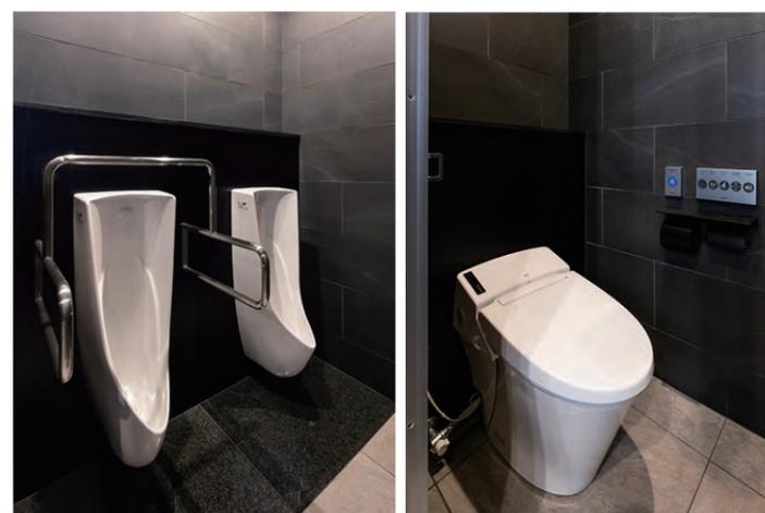
小便器は体を支える手すり付き。下には汚垂石を設置し清掃面に配慮。独立した大便器洗浄リモコンは大型で見やすく、操作するたび発電するので電源不要。
