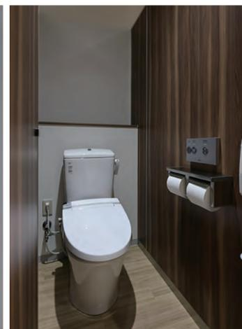
大便器にはレジリエンストイレを採用。断水時には洗浄水量を5Lから1Lに切り替えられるため、断水時にも使い慣れたトイレをそのまま利用できる。小便器は床面の清掃性が高い壁掛式で、汚れやすい便器下には汚垂石を設置。
