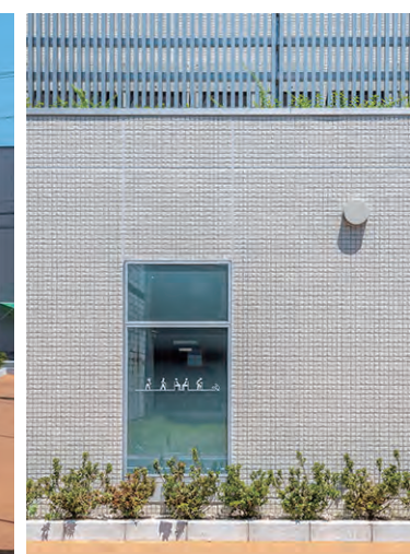
西面 外装壁面
