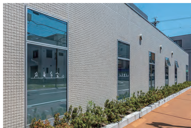
西面 外装壁面
