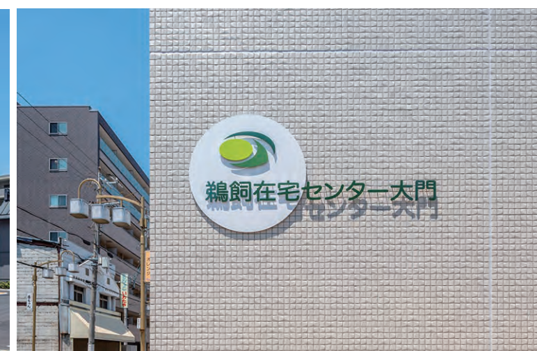
南面 外装壁面
