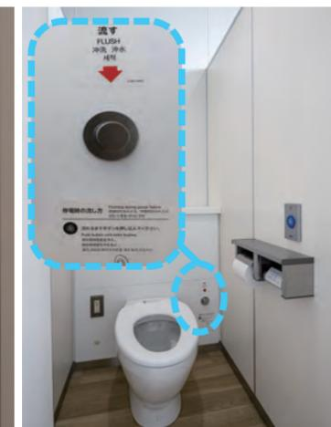
壁掛式の小便器は、便器下に空間があることで掃除がしやすく、尿垂れを考慮した汚垂石も設置し、清掃性に配慮している。大便器は停電対応仕様で、通常の洗浄スイッチが作動しない場合でも手動で洗浄することができ、万が一の際にも安心。ボタンの横には5カ国語で使い方を表示している。
