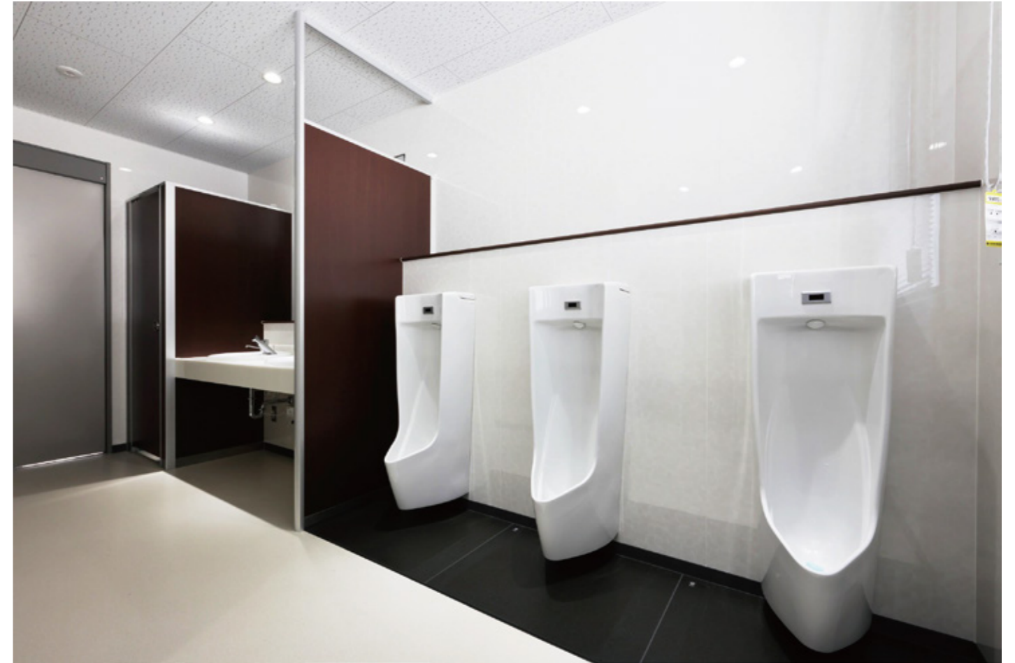
2F 男性用トイレ 洗面・小便器
