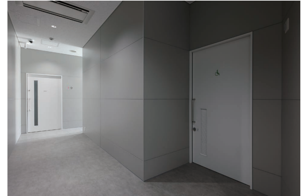
バリアフリートイレ(西) トイレ入り口まわり
