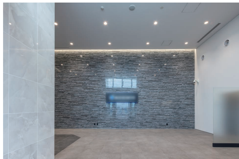
エントランスホール 内装壁タイル・内装床タイル
