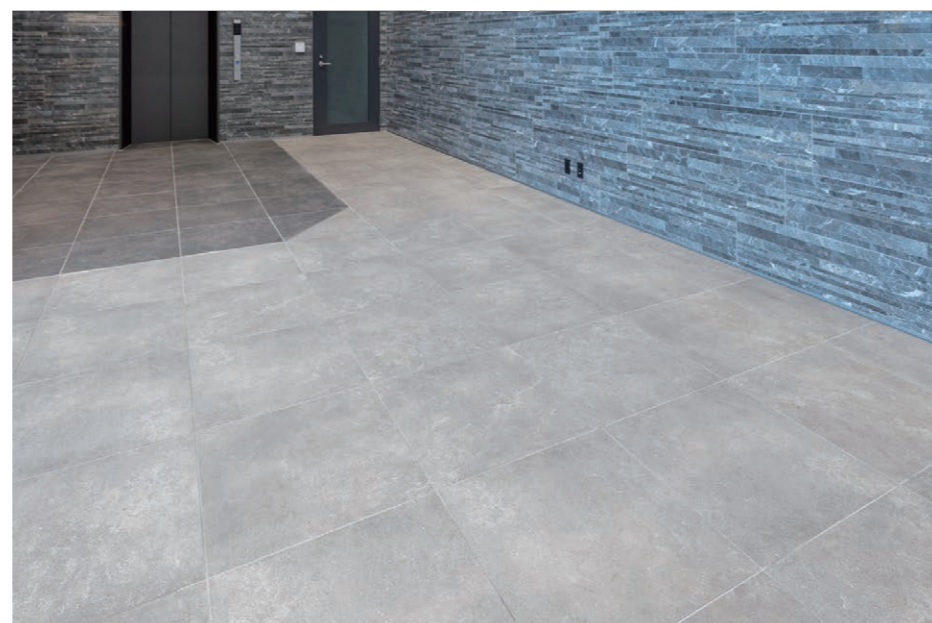
エントランスホール 内装床タイル
