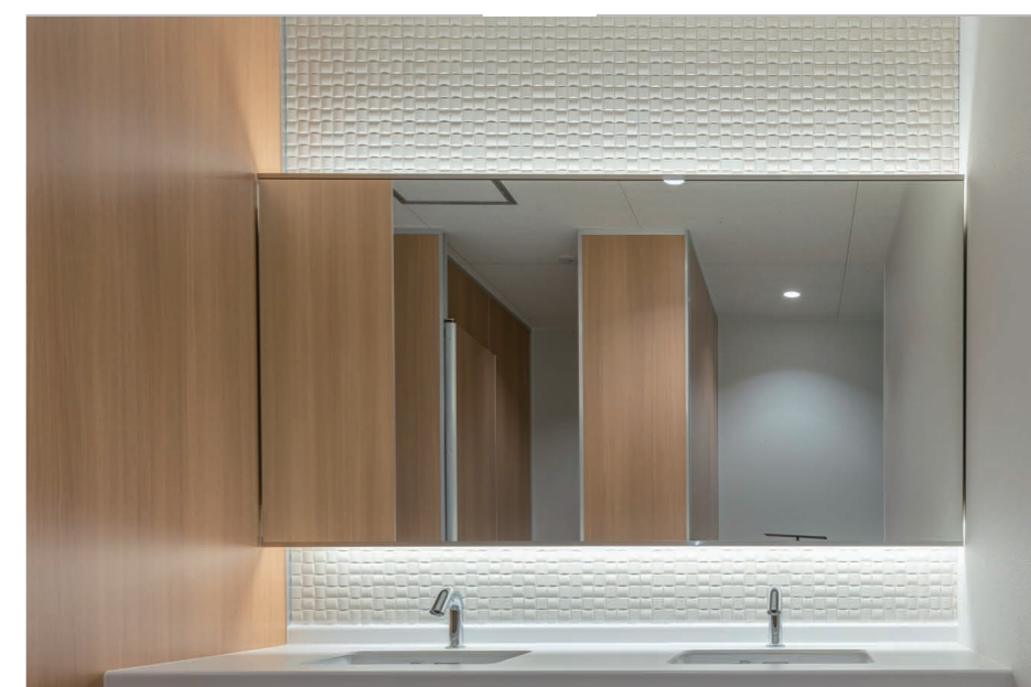
トイレ 内装壁タイル
