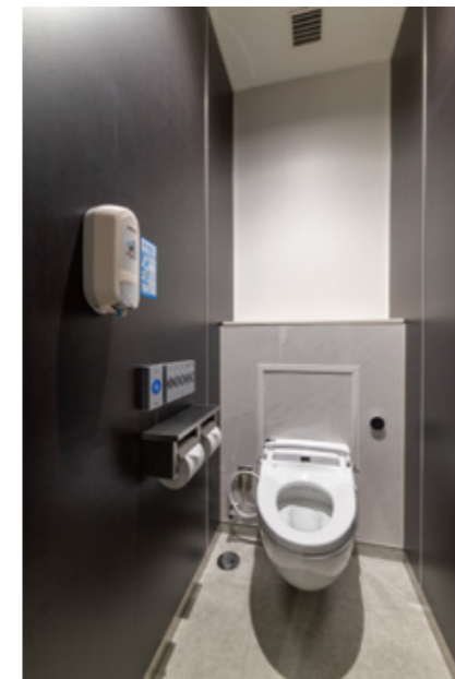
女性用トイレ 大便器
