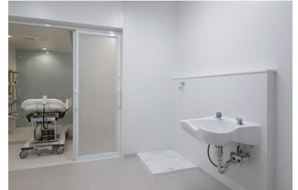
2F 脱衣室 洗髪器
