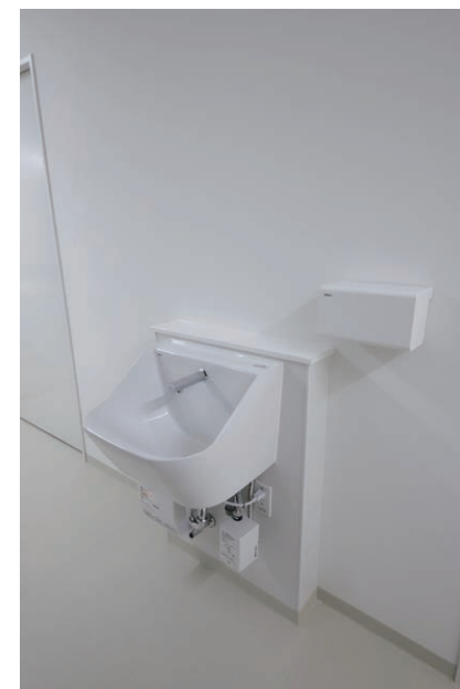
1F スタッフ通路 洗面器
