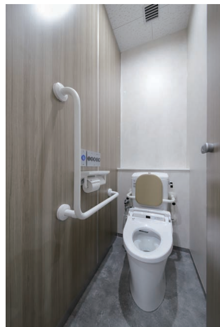
1F 男性用トイレ 大便器
