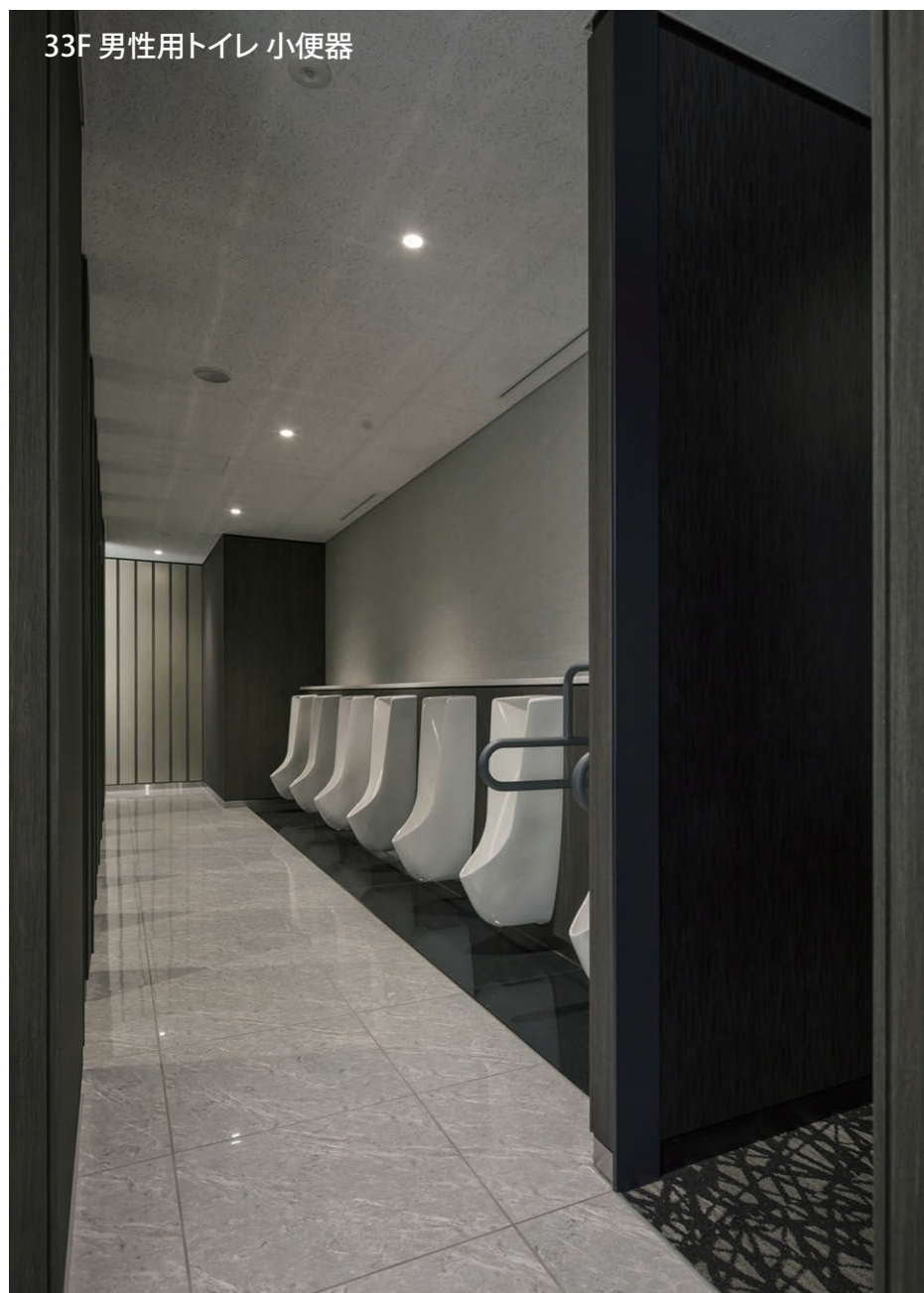
トイレ入り口を2箇所に設け、異なるエリアからもアクセスしやすくなっている。
