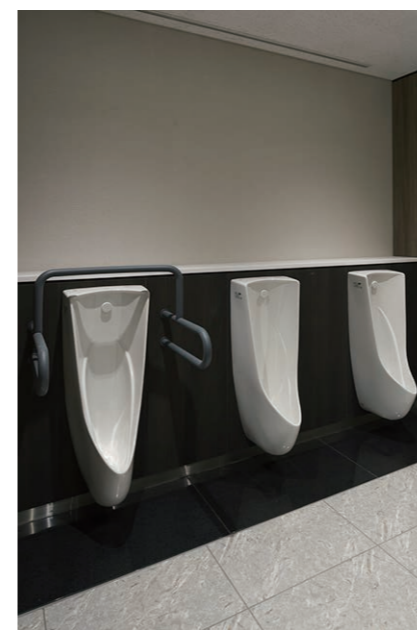
B1F 男性用トイレ 小便器
