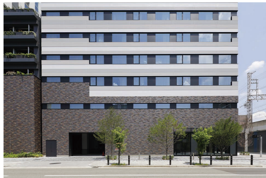
C敷地 外装壁タイル
