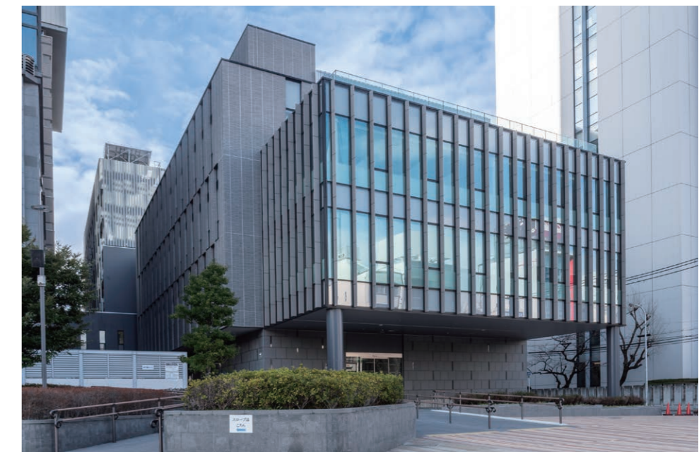
外観壁面 北東側
