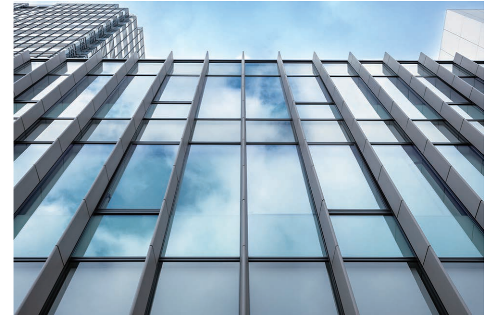
外装壁面 北側 (見上げ)
