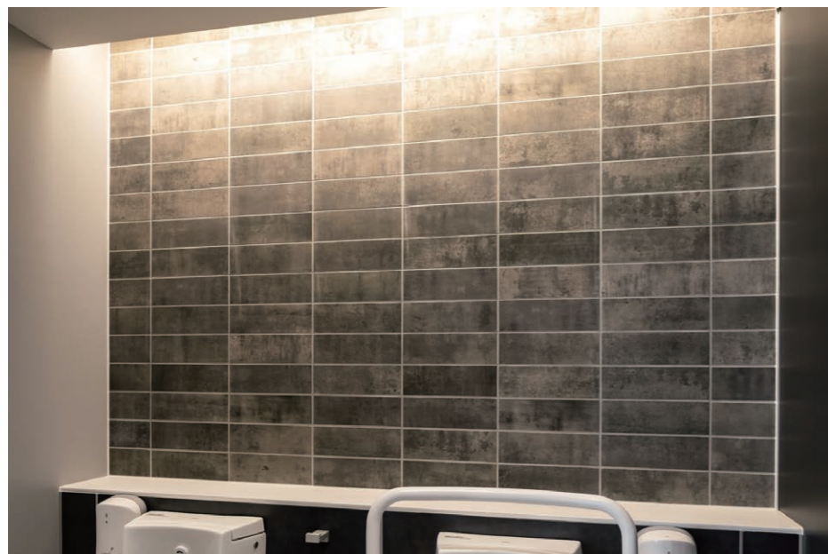
1F 男性用トイレ 内装壁タイル
