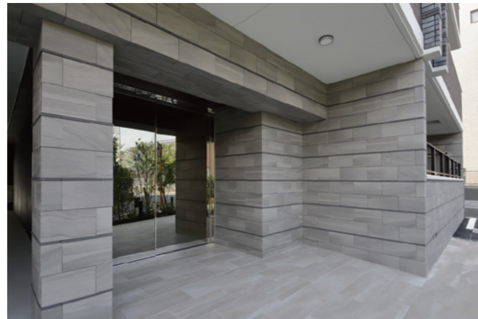
エントランス 外装壁面
