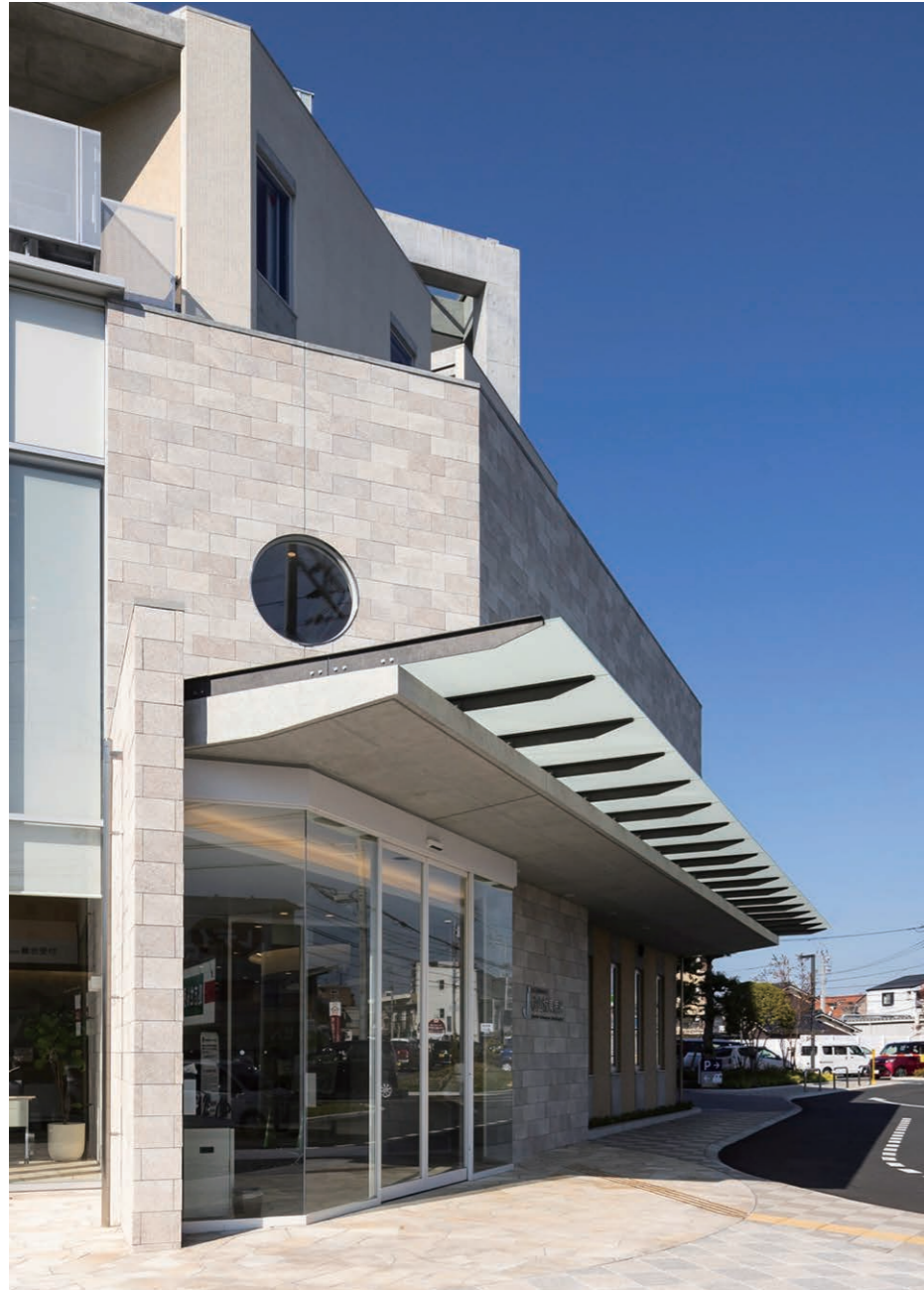
外装壁面 東側
