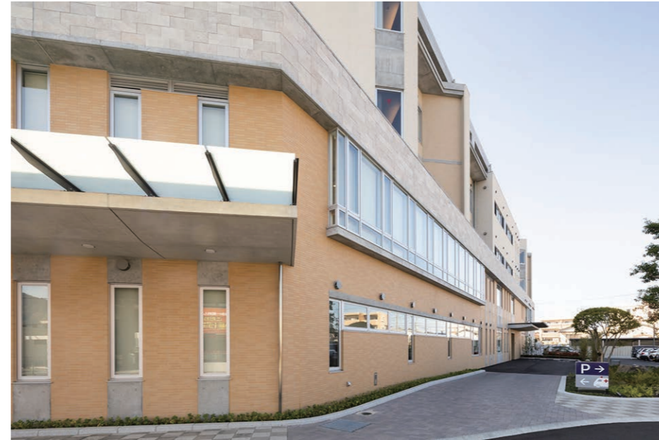
外装壁面 北東側
