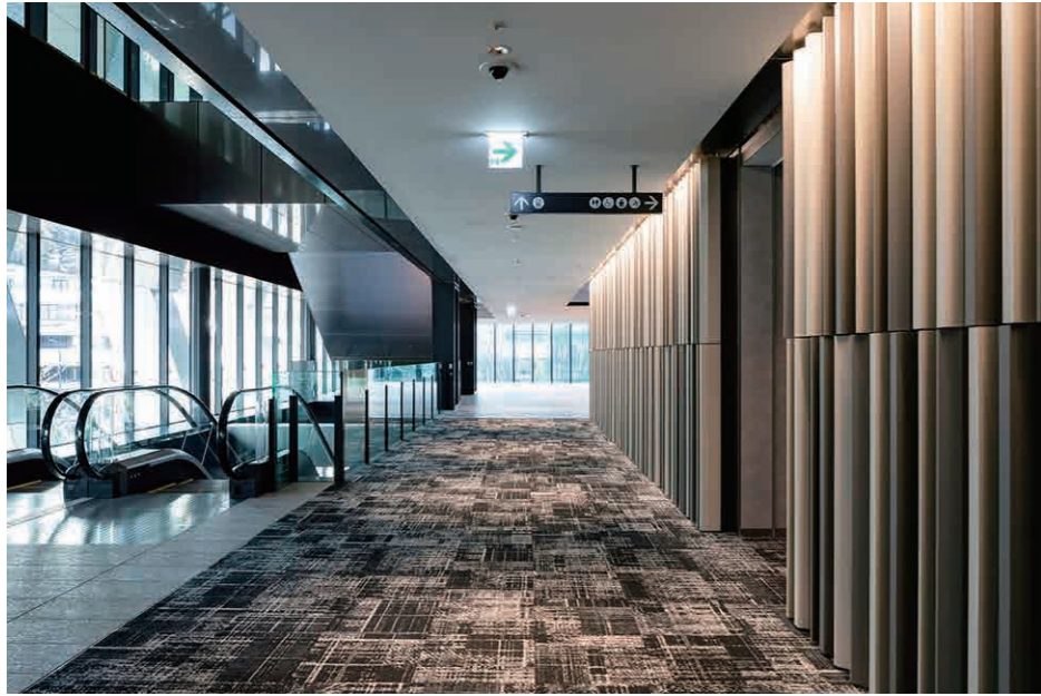
2F 内装壁面 テラコッタルーバー
