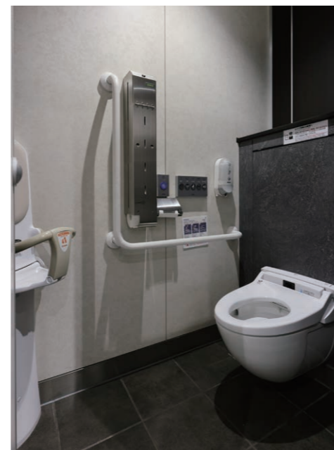
詰まり検知センサー（楕円部分）が付いたIoTトイレが水があふれを未然に防止。
