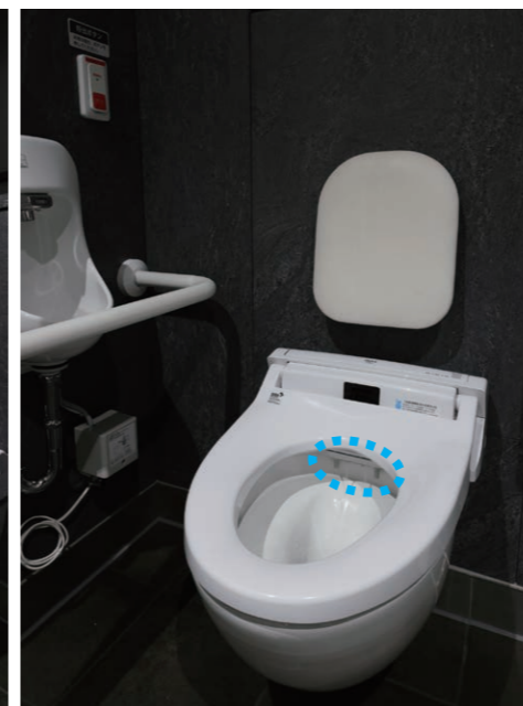
詰まり検知センサー（楕円部分）が付いたIoTトイレが水があふれを未然に防止。
