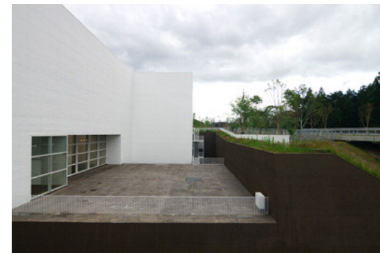
1階南側から見たトレンチと建物
