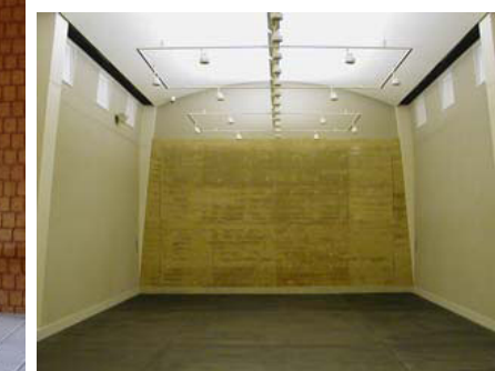
「版築工法」のできた企画展示室の土壁
