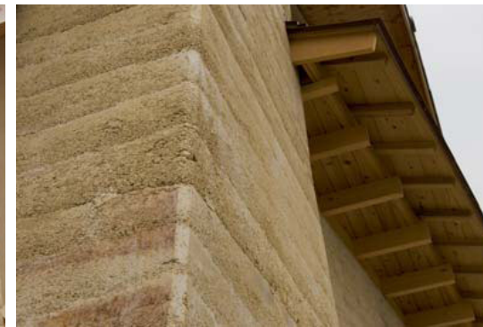
建物の版築壁コーナー部
