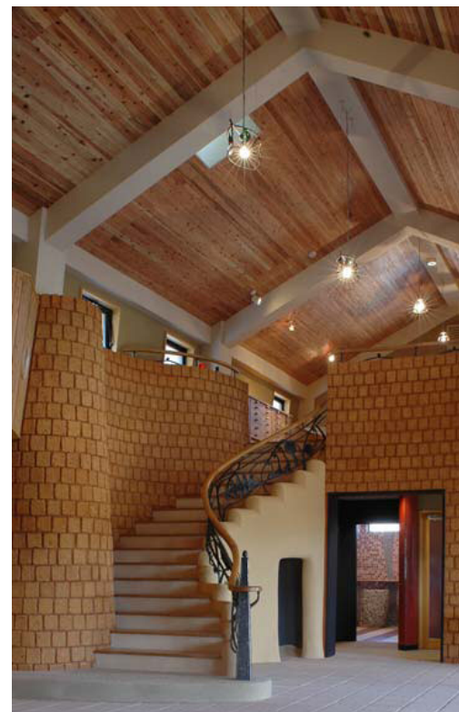
日干しレンガを積み上げた階段部分
