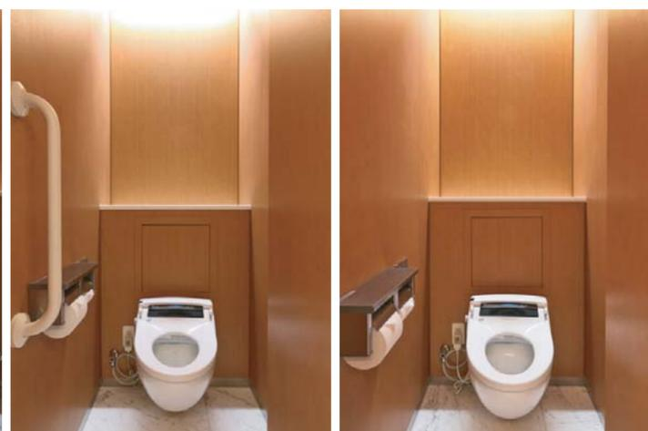
大便器・小便器ともに壁掛式を採用。大便器は給水隠ぺい型のすっきりとした形状、小便器は凹凸の少ないシンプルな形状で、1クラス上のトイレ空間を演出。節水性にもすぐれており、大便器はパブリック向けで洗浄水量6Lを実現したECO6、小便器は使用状況に応じて自動で洗浄水量を調節するスーパーAI節水機能を搭載。
