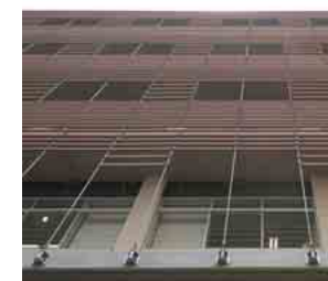
東側正面見上げ
