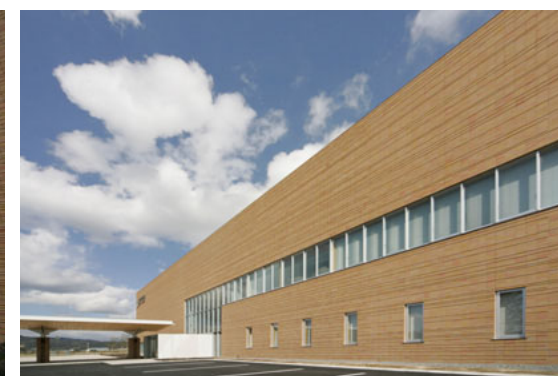
西側の外壁面
