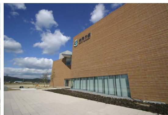
西側の外壁面
