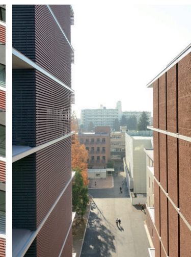
接続通路より遠景
