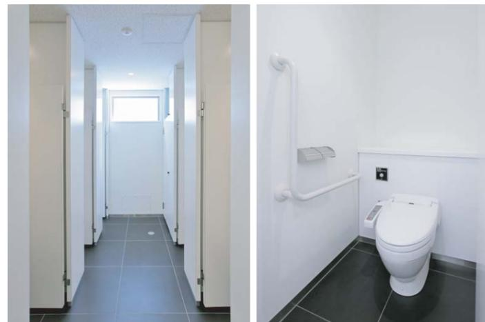
ブース間の仕切りは天井まで立ち上げられ、落ち着きとプライバシーを確保。大便器は6L洗浄の超節水型。男女とも個室ブース各1ヶ所にはL型手すりを設置。
