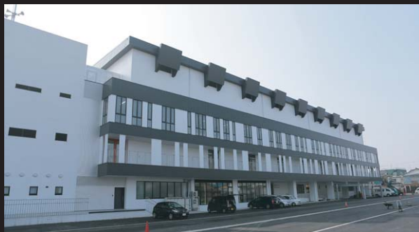
体育館棟外観
