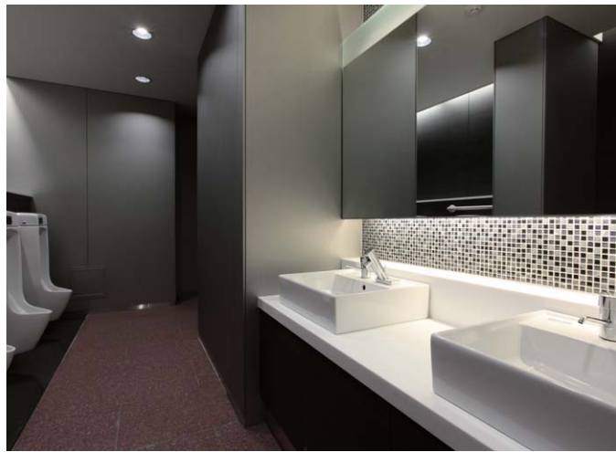
小便器はセンサー一体型のストールタイプに、水栓は自動水栓、大便器も洗浄方式をセンサータイプとし、節水に繋がるだけでなく、機器に触れることなく衛生的に利用できる
