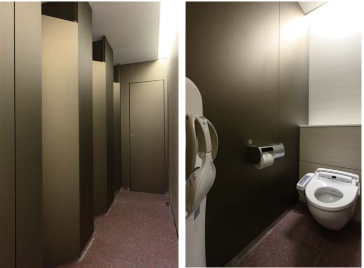
擬音装置付きのシャワートイレで洗浄回数を減らし節水に配慮している。女性用トイレにはベビーキープも設置さし子連れでも利用しやすいように配慮されている
