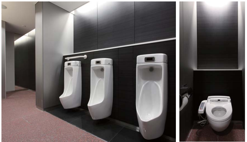
小便器はセンサー一体型のストールタイプに、水栓は自動水栓、大便器も洗浄方式をセンサータイプとし、節水に繋がるだけでなく、機器に触れることなく衛生的に利用できる
