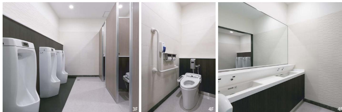
1～2L洗浄の小便器、6L洗浄の大便器など、男女トイレとも優れた経済性・清掃性・省エネ性能を持つ器具に一新。手洗いには機能性とデザイン性を両立させたノセルカウンターを採用。手荷物やショッピングバッグを置きやすい広いドライエリア、清潔感のある非接触型自動水栓・オートソープで、集客アップにもつながる快適性の高い空間に。
