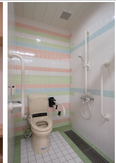
脱衣室トイレ / 失禁対応シャワーを設置
