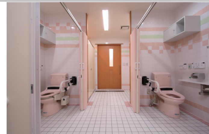
大便器ブース / 右仕様・左仕様を設置
