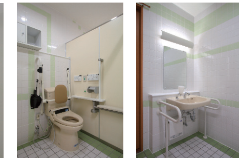
大便器ブース / 前方ボードを設置
