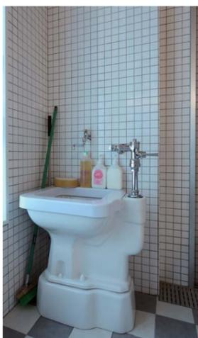
汚物処理室には洗濯機他、補高台が付いた使いやすい高さの汚物流しと掃除流しを設置している。
