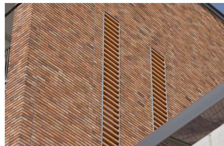
南東側見上げ
