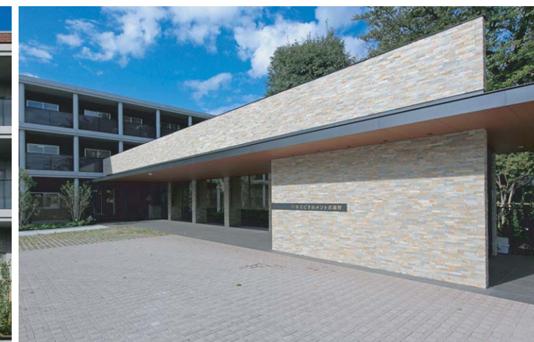
エントランス全景
