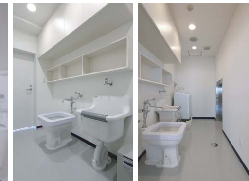
1F~6F汚物処理室
