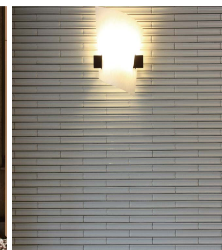
壁面タイルと照明
