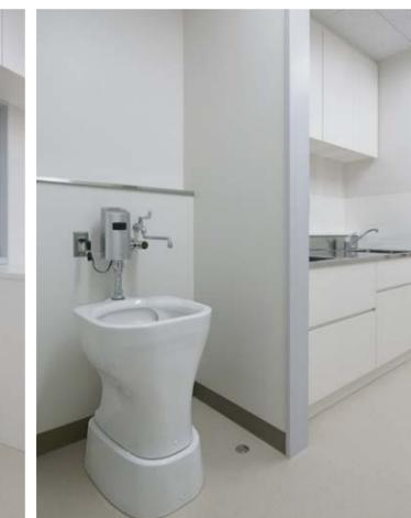
常に清潔さを要求されるスタッフステーションには、感染防止の徹底対策として入り口付近にスタッフ専用の手洗器、隣接する準備室には鉢開口型の汚物流しを設置。いずれも防汚やメンテナンス性に優れたものを採用。
