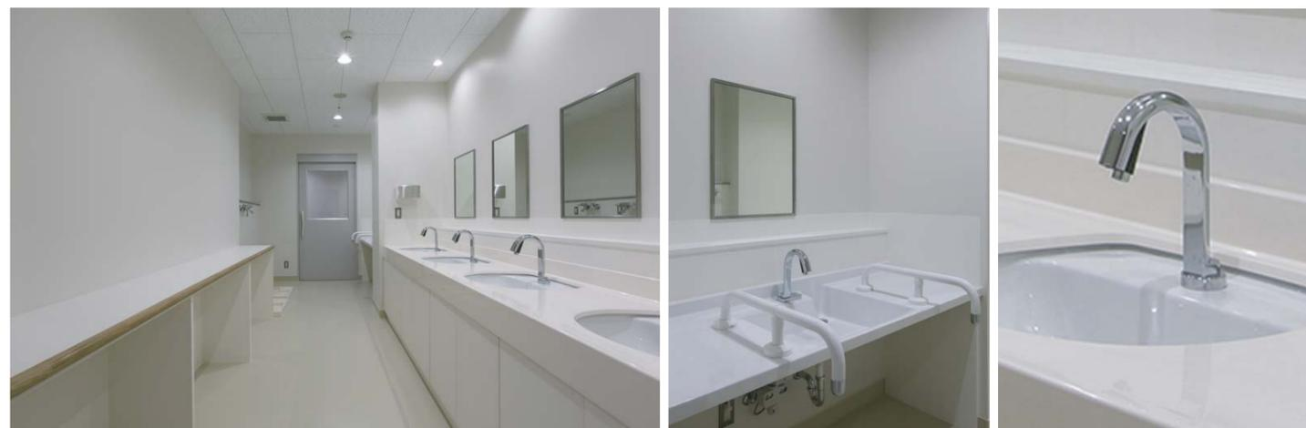
洗面スペースの向かいにはカウンターが設けられる。水栓は自動水栓により非接触、吐水口空間を広く確保できるゲースネック形状を採用する事により、使用者の衛生面と使いやすさに配慮されている。
