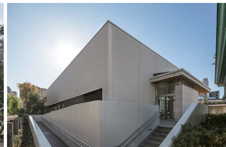
エントランス外装壁面
