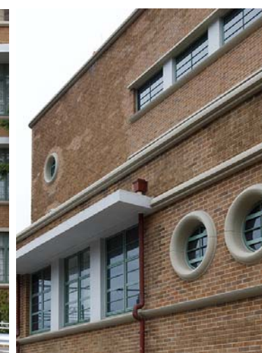
壁面と開口部
