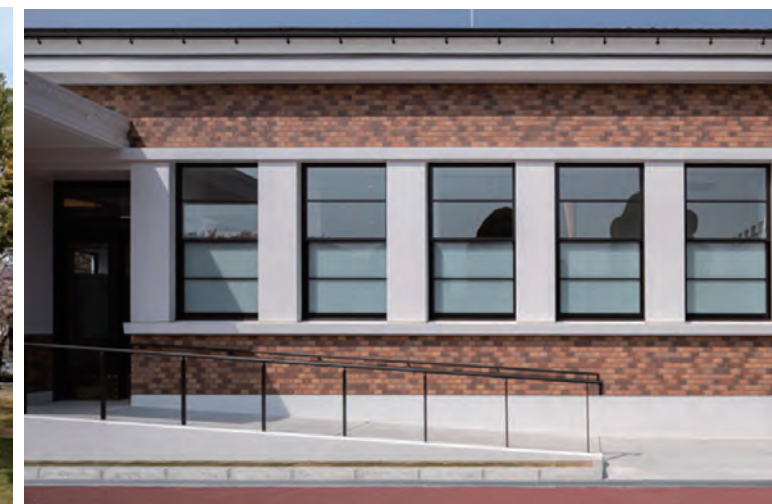
正面外装壁面
