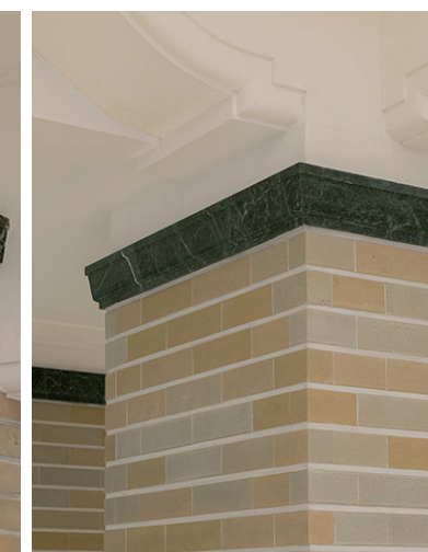
新設したタイル
