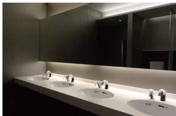
鏡裏の照明が手元の明るさを保ちながら、空間の演出性も高めている。洗面カウンターには非接触で衛生的な自動水栓を採用。
