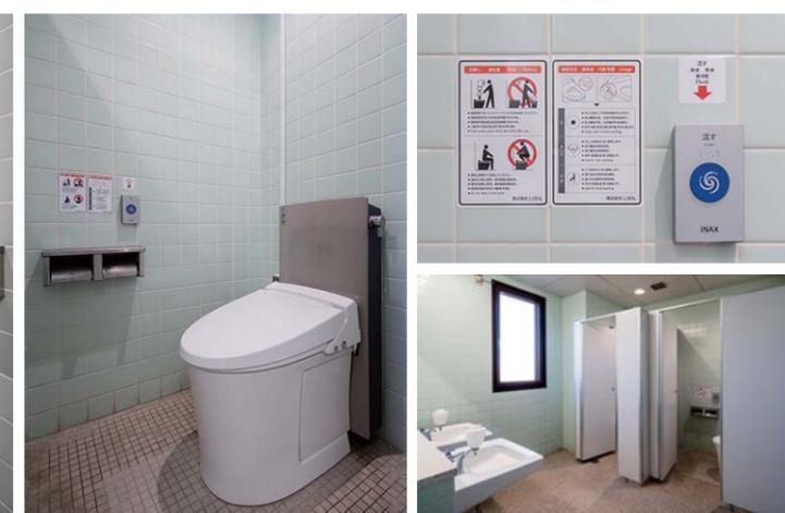
洗浄ボタンは操作するたびに発電する電源不要の発電式。5か国語でトイレの使い方と洗浄ボタンを解説したシールを貼り、外国人の来館者にも配慮。
