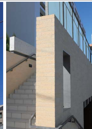
東南側低層部壁面
