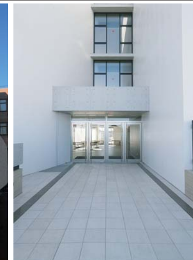
2階エントランス外床
