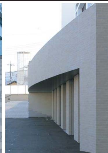
北東側低層部壁面
