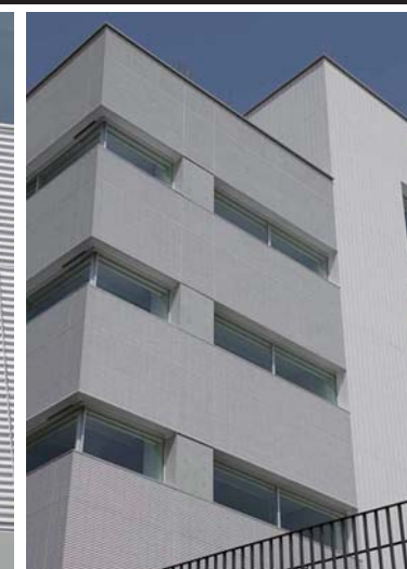
南側外装壁中景
