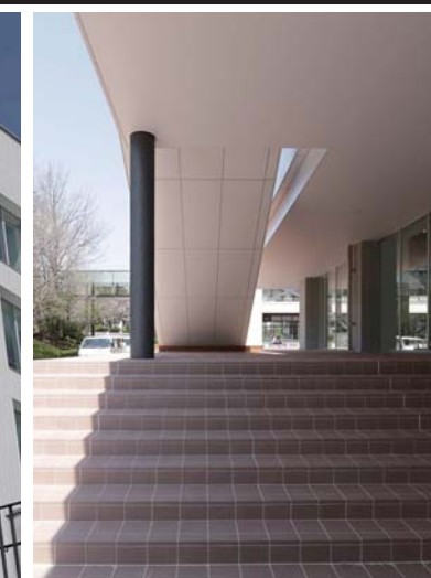
外構・階段部床タイル
