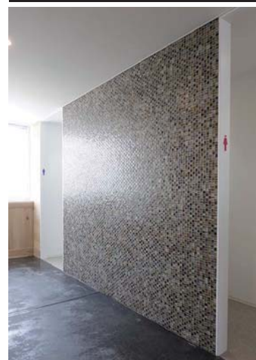
男女トイレ出入口内装壁タイル
