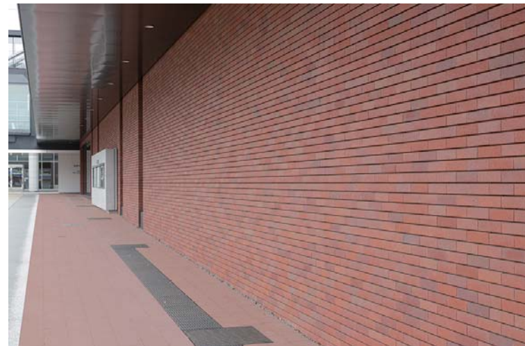
通路外装壁面
